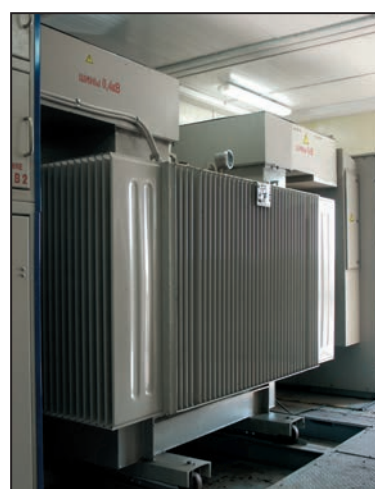
ТМГФ-СЭЩ® в составе КТП промышленного типа
